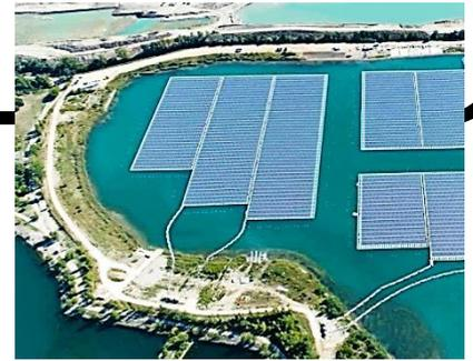
Le 18 octobre 2019, la France inaugure sa première centrale photovoltaïque flottante. Installée sur le lac artificiel de Piolenc dans le Vaucluse, elle possède une puissance maximale de 10 MW et un meilleur rendement que si elle était située sur terre ferme.
